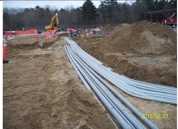
UG Electrical Conduit Installation
