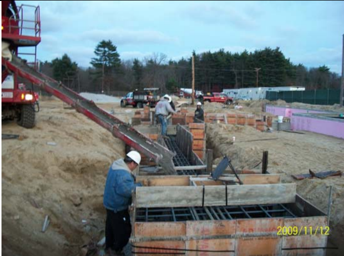
V-Line Pier & Grade Beam Pour
