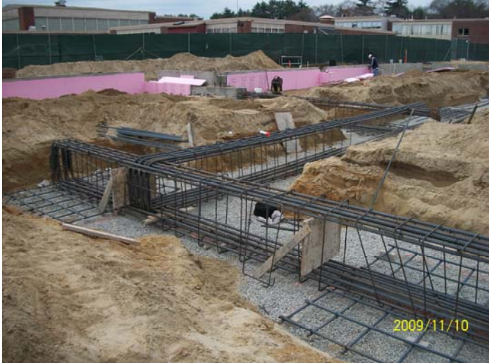
V-Line Pier & Grade Beam Pour
